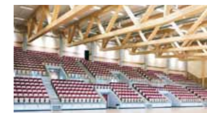
Idrottshall med limträbalkar.
